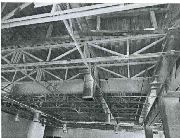
Fotografía 2. Instalaciones eléctricas expuestas, observadas durante el recorrido de verificación.
