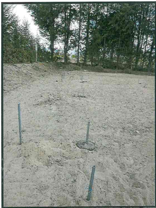
CIMENTACIÓN DE LA BASE PARA EL INVERNADERO EN VIVERO SEDIF.
